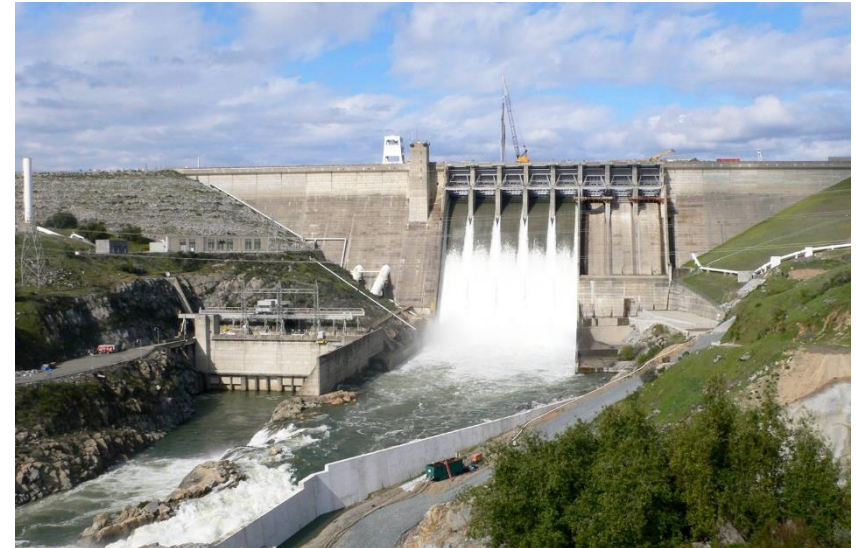
Folsom Reservoir Spilling
